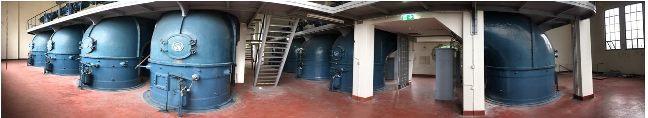
Maastunnel | Rem de Tender | Datum 7 februari 2024 Rotterdam
