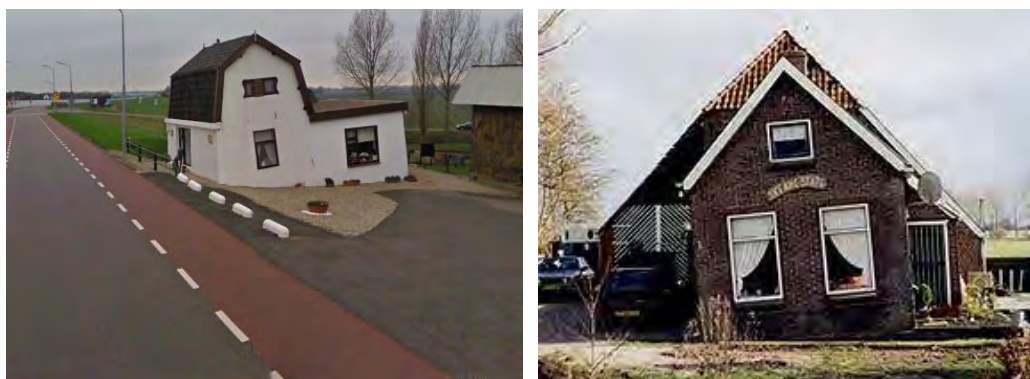
Figuur 4.2.9 Scheefstand veroorzaakt door ongelijke zettingen; (bron: Geomet)
