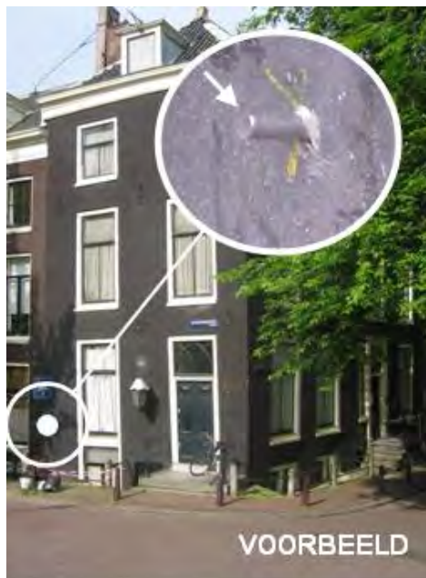
Figuur 8.12.1 Voorbeeld hoogtemeetbout
