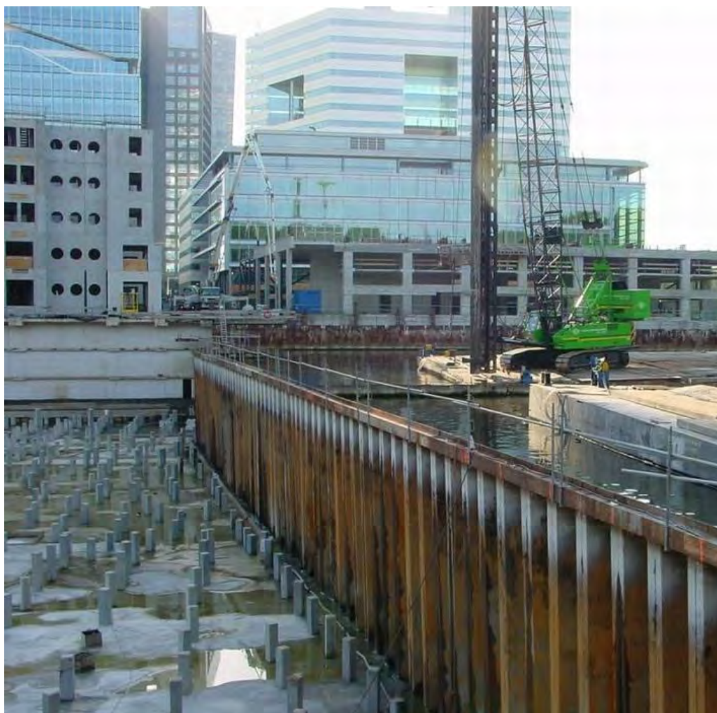
Figuur 5.1.1 Grondkerende constructies; (bron: Voorbij Fun- deringstechniek)
