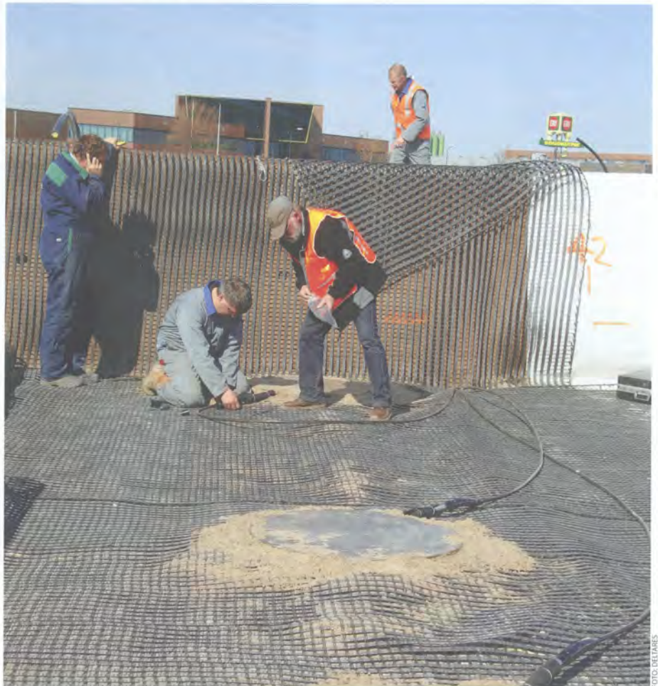
Aanbrengen van de meetinstrumenten in de paalmatras bij Woerden.
