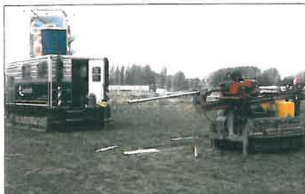
↑ Figuur 2 Sonic Drill van Eijkelkamp en rups van GeoDelft voor Begemann- en Spitsmuisboring, locatie Broekpolder.
