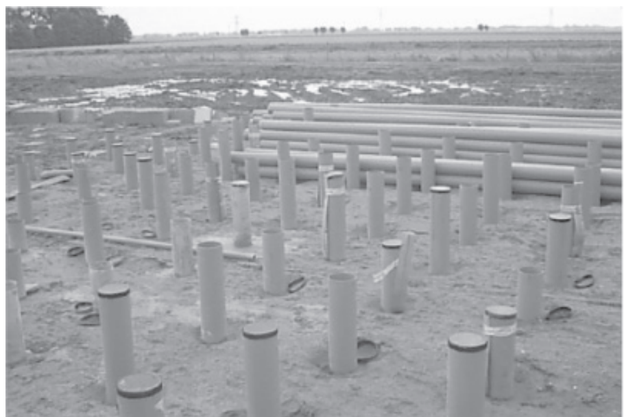
Figuur 11.1b Aanbrengen paalfundering terp HW5 (uit [5])
