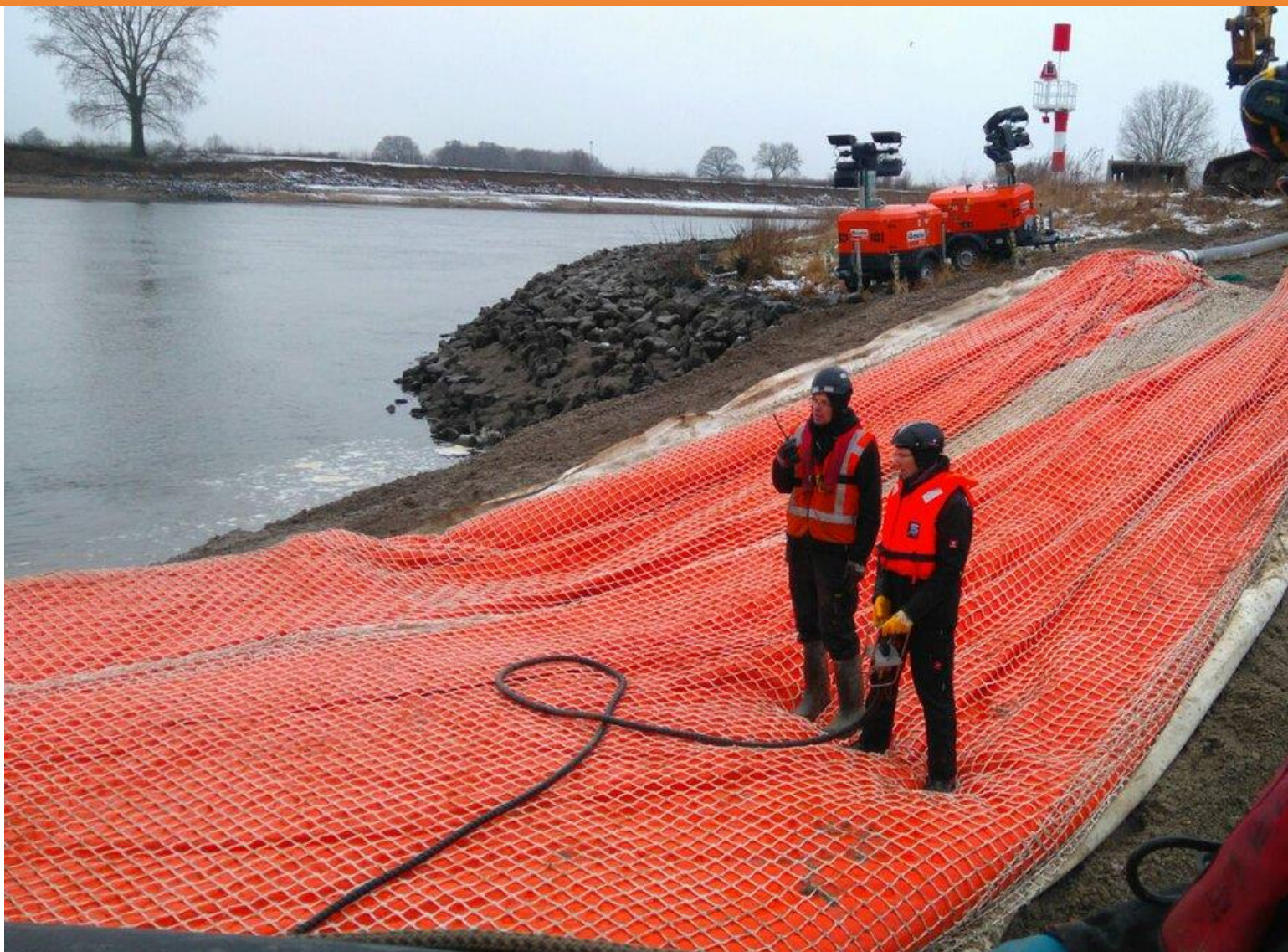
plaatsen Mobile Dijk
