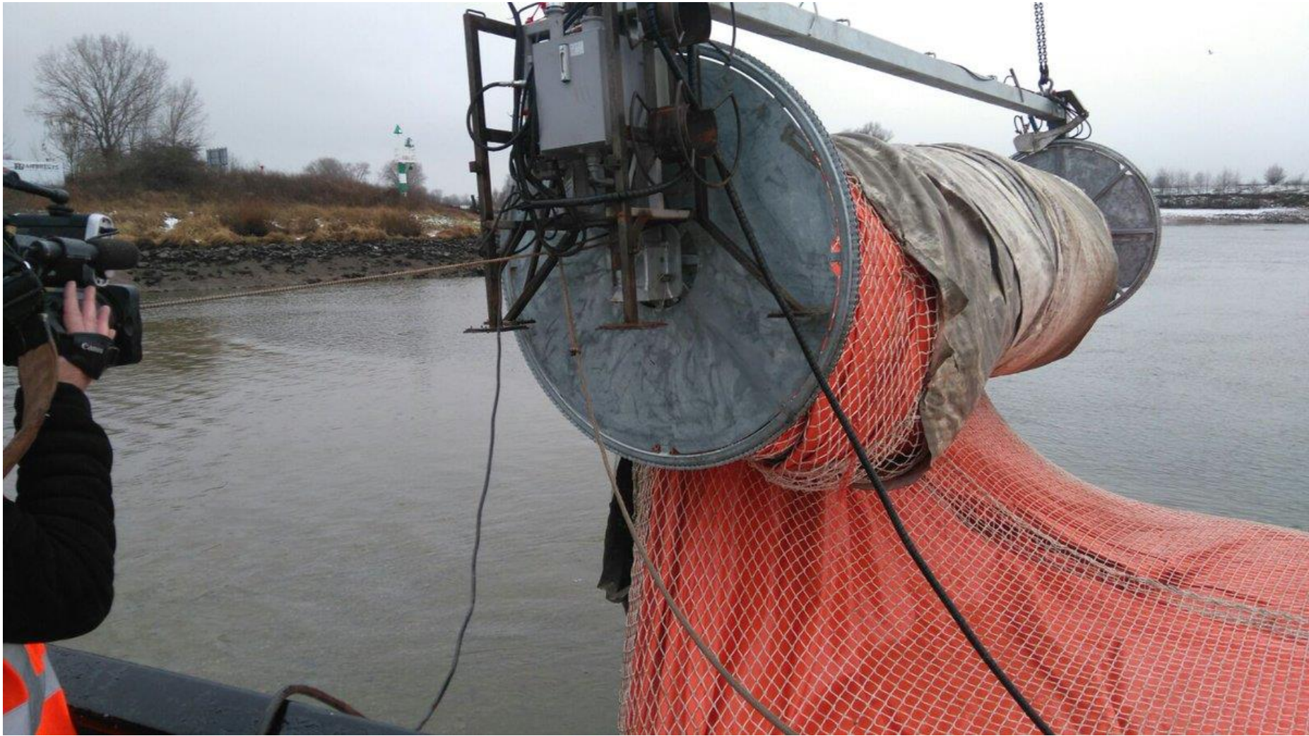
plaatsen Mobile Dijk
