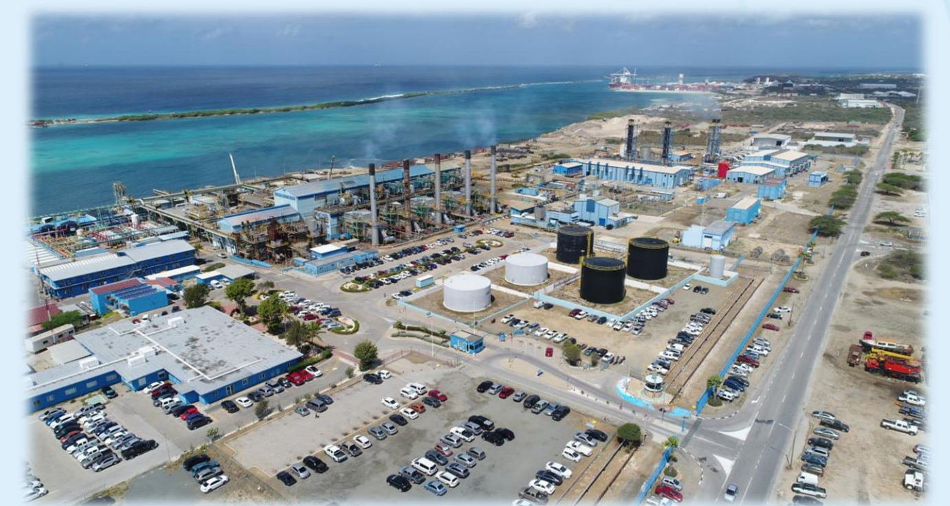
WEB Aruba N.V. | Water- en Energiebedrijf Aruba N.V.
