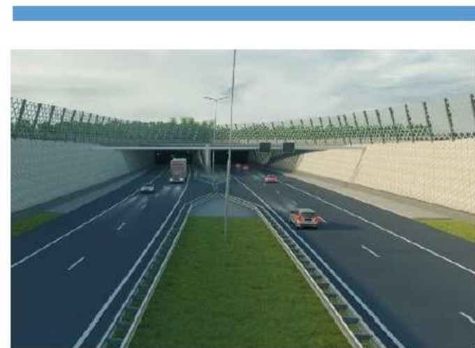
Foto's: Rottemeren tunnel
